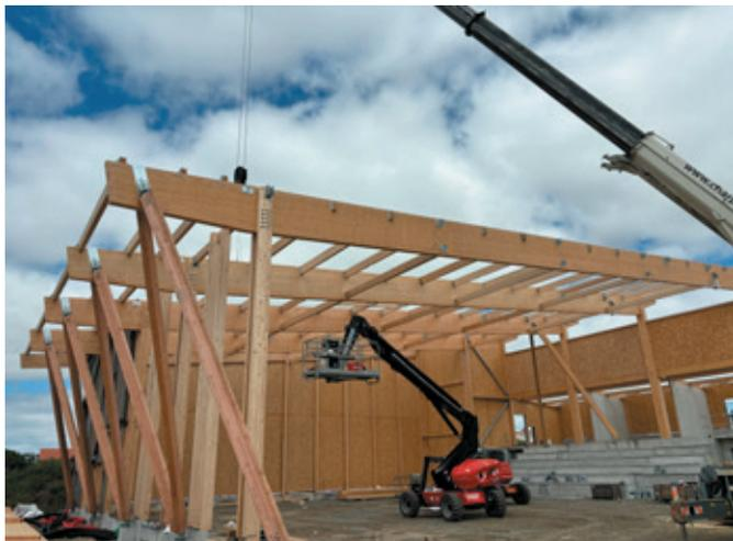
Cinq semaines ont été nécessaires pour la pose de la charpente, nécessitant des moyens de levage conséquents.
