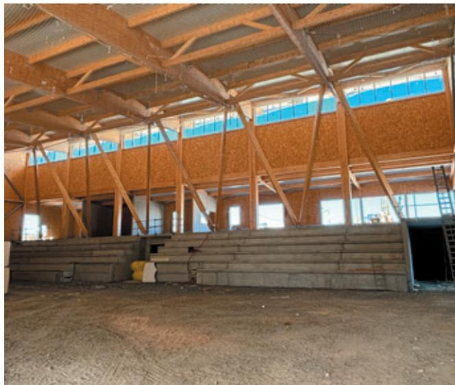
La préparation de la dalle va commencer afin de mettre en place un isolant de 10 cm, une dalle de béton armé de 13 cm, puis le revêtement sportif qui se compose de trois couches : un matériau résilient (mélange de liège et de caoutchouc), un contreplaqué et une résine de finition.
